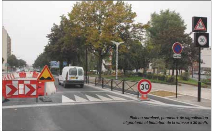
Plateau surélevé, panneaux de signalisation clignotants et limitation de la vitesse à 30 km/h.
