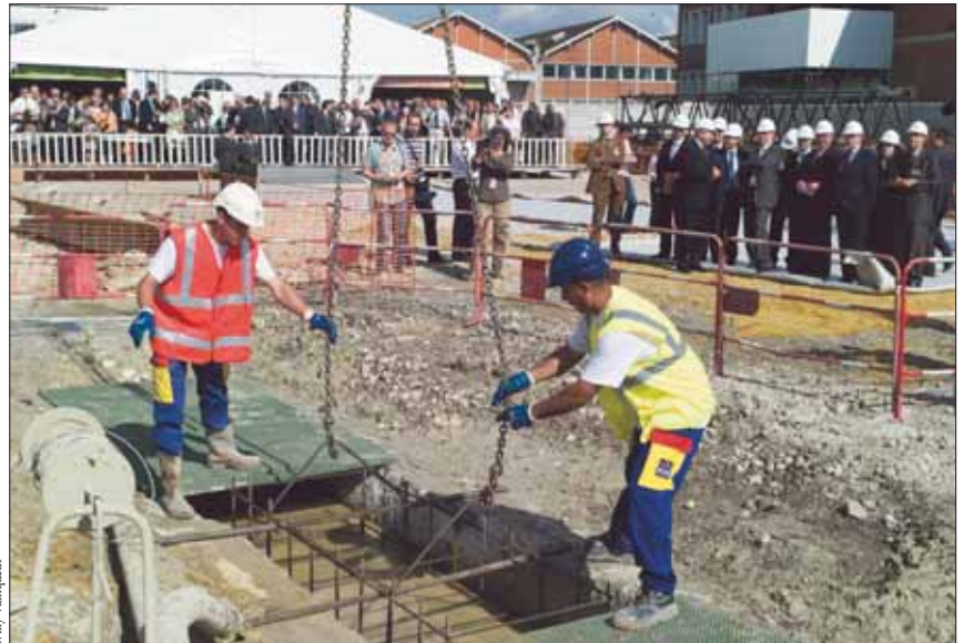
La première tranchée pour l'énorme chantier du prolongement de la ligne 12 du métro. Le tunnelier, en cours de construction en Allemagne, rentrera en action au deuxième trimestre 2009.
