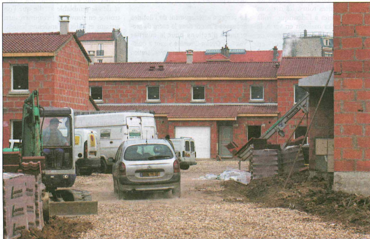
La Villa Aragon a commencé à sortir de terre. Bordé par la rue des Ecoles, la rue des Cités et la rue Henri Barbusse, le nouvel îlot va s'étendre sur une parcelle de 8 600 m 2 . Ce programme en accession comprend un immeuble R+3 de cinquante-trois logements et vingt maisons de villes. La fin des travaux est prévue pour le début 2003.
