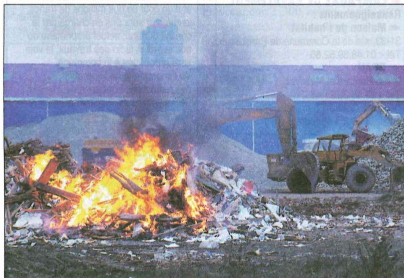
Depuis le début de l'hiver, les Etablissements et magasins généraux de Paris (EMGP) sont en train de faire place nette autour du bassin de la darse, à proximité du canal. Plusieurs vieux entrepôts viennent d'être démolis. C'est sur ce site que verra le jour le futur centre commercial de la Porte d'Aubervilliers. Avec, en vis-à-vis, côté Paris, le parc du Millénaire. Un programme de 100 000 m 2 de bureaux et d'activités.
