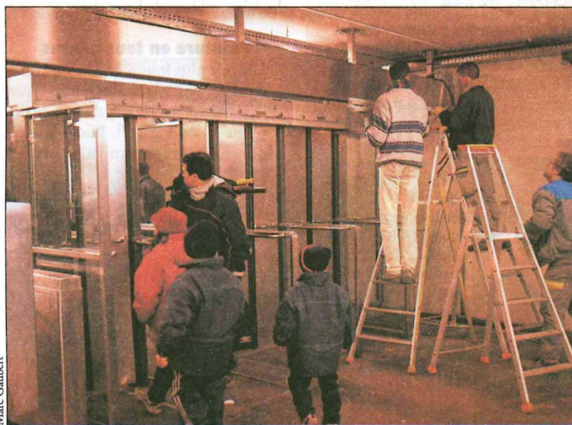
Les ouvriers mettent la dernière main à la rénovation de l'éclairage de la station de la ligne 7.
