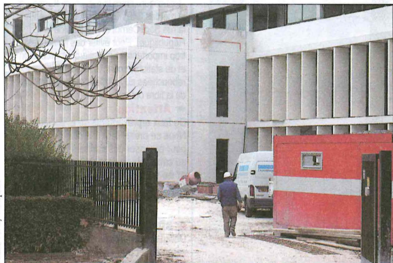
Commencée en 2000, la réhabilitation du lycée Le Corbusier va se poursuivre jusqu'en 2003. Le bâtiment de quatre étages qui regroupait les classes et les ateliers sera remplacé par un nouvel ensemble dont la première partie est actuellement en construction sur le terrain de sport. Financé par la Région, cet énorme chantier est estimé à 27,4 millions d'euros (180 millions de francs).
