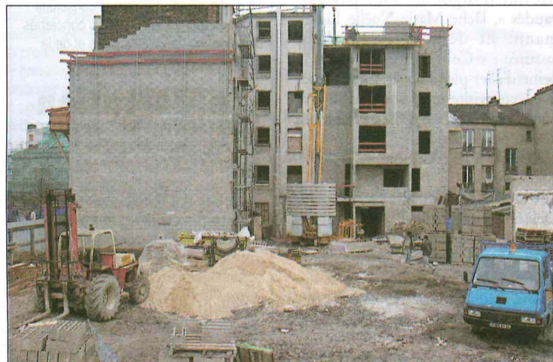
123, avenue Henri Barbusse, l'ancien hôtel meublé Prima a été racheté par le Pact'Arin, association de restauration immobilière, qui ouvrira une résidence sociale courant 2002.
