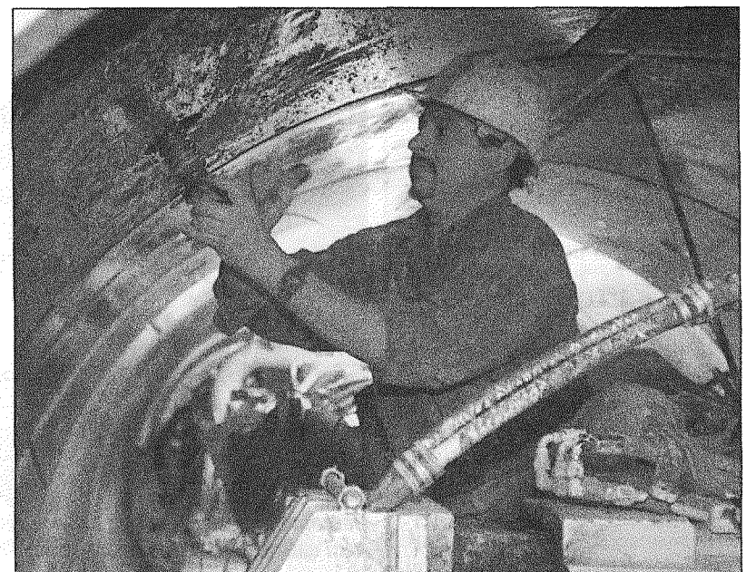
Tous les deux mètres de progression, des plaques en béton préfabriquées sont fixées pour former la paroi de l'ouvrage.
