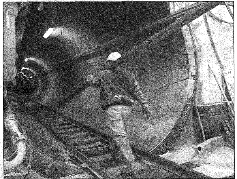
Long de 700 mètres, le tunnel est éclairé et ventilé. Des tuyaux servent à acheminer l'air et l'eau de refroidissement des moteurs du tunnelier.
