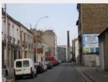
Perspective de la cheminée de l'ancienne manufacture d'allumettes depuis la rue Henri Barbusse [1603] Phot. A. Furio - © Département de la Seine-Saint-Denis
