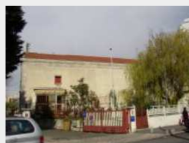
Entrée du magasin R' de l'ancienne manufacture d'allumettes [1604] Phot. A. Furio - © Département de la Seine-Saint-Denis
