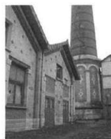
16. Les bâtiments techniques autour de la cheminée
