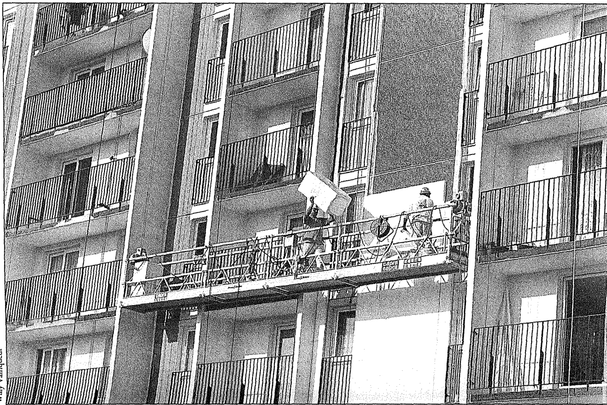
La réhabilitation concerne 216 logements au 21-25 rue du Pont Blanc pour un montant de 15,7 millions de francs.
