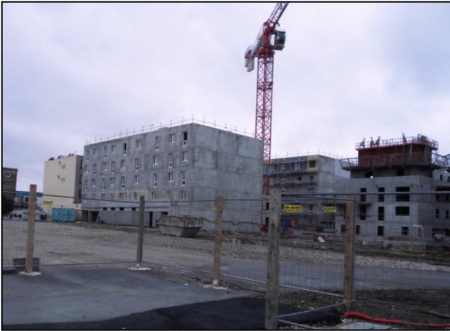
Travaux au 15-21 rue Gaëtan Lamy en décembre 2013
