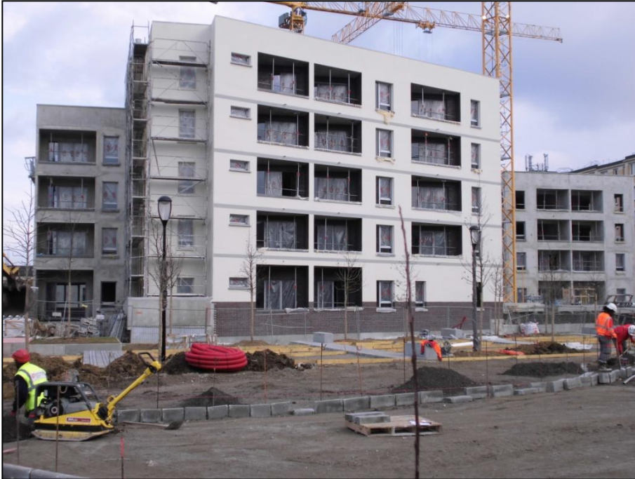
Photo du chantier en décembre 2013
