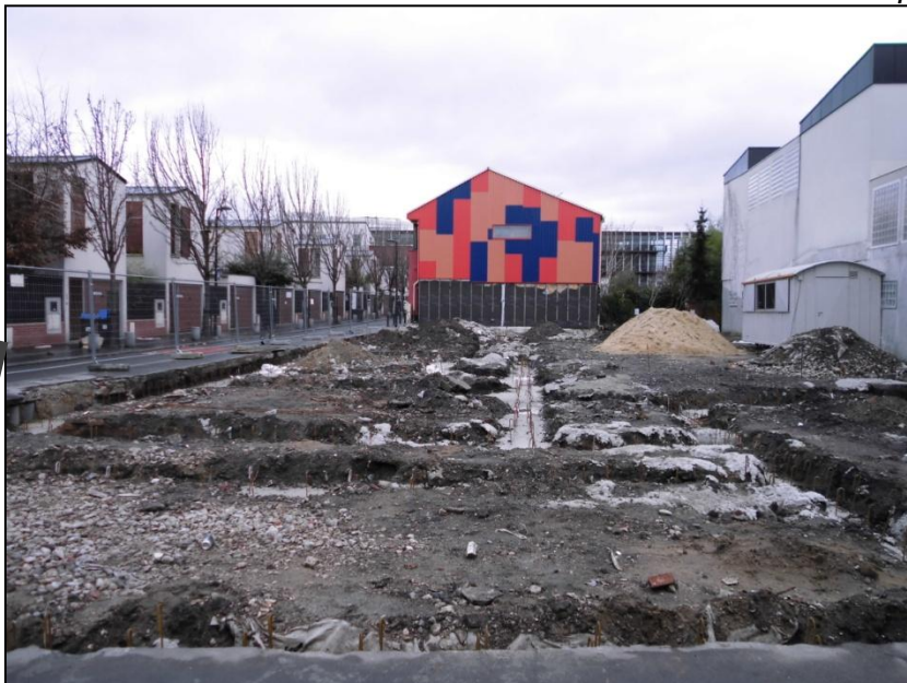
Travaux en cours en décembre 2013
