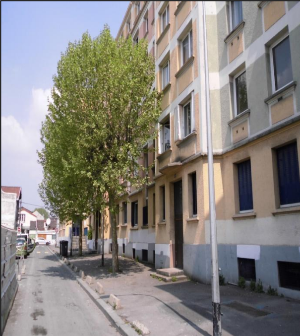
Rue Albinet avant les travaux
