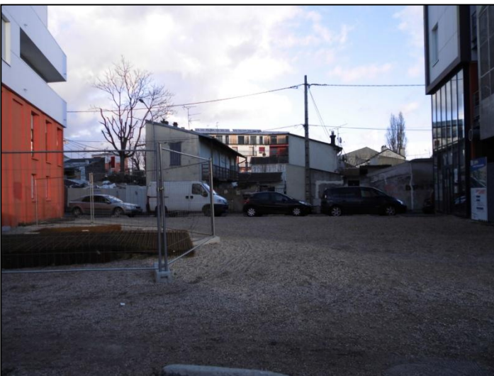
Parvis de la PMI avant les travaux
