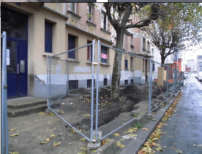
Travaux de résidentialisation en cours (décembre 2013)
