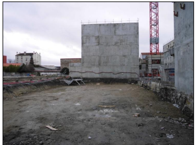
Travaux au 13 rue Gaëtan Lamy en décembre 2013
