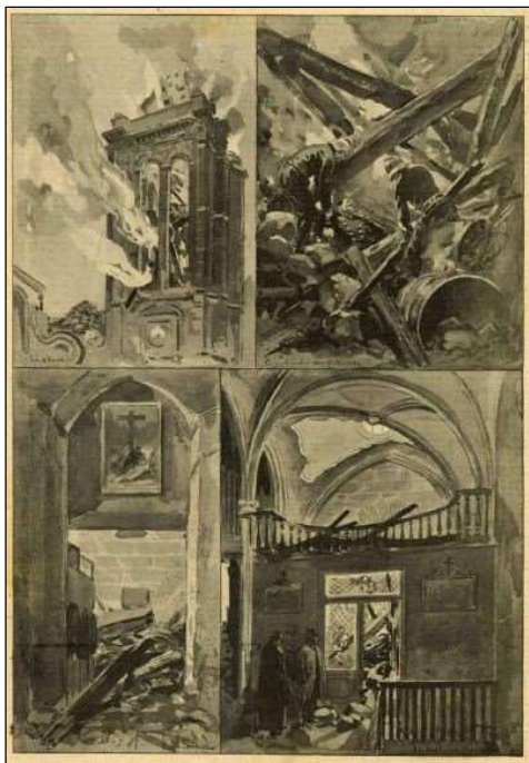
Les dégâts suite à l'incendie Le Journal illustré – 29 avril 1900 AM Aubervilliers – AUB/1803
