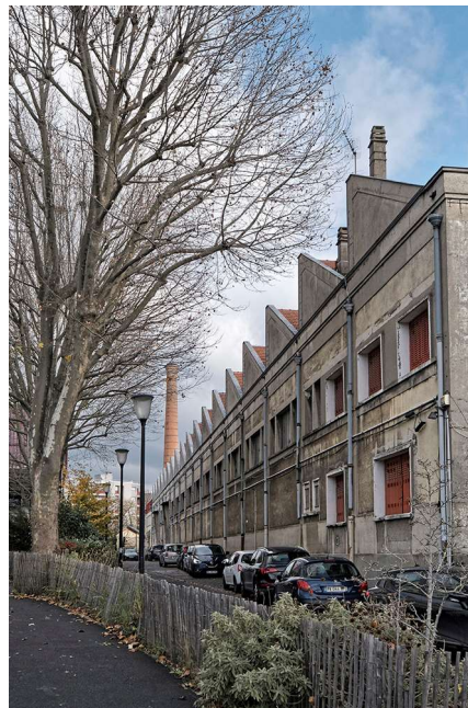
Bâtiment de 18 sheds rue de Presles (photo DH)
