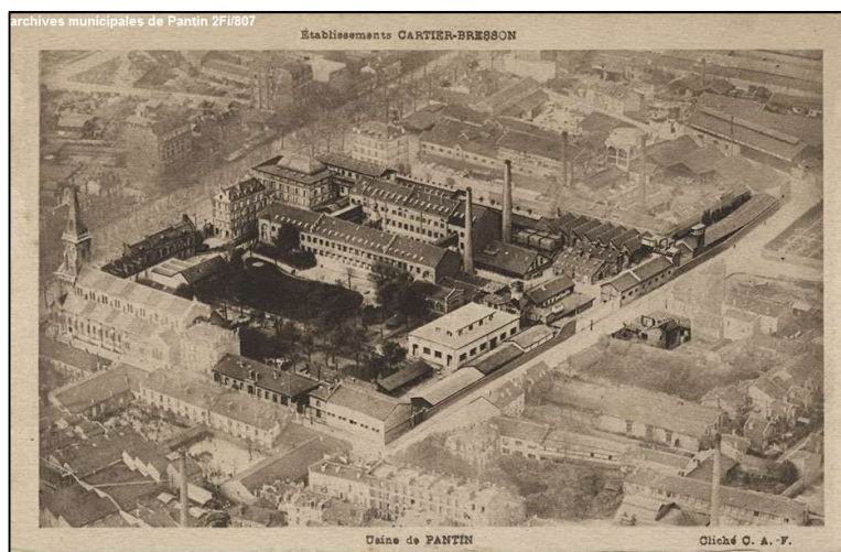
L'église Sainte-Marthe à gauche, jouxtant l'usine Cartier-Bresson – (début du XX e siècle)
