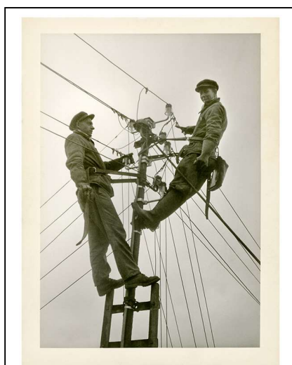
Deux électriciens en haut du potelet
