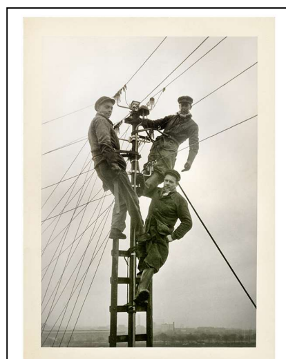
Trois électriciens en haut du potelet
