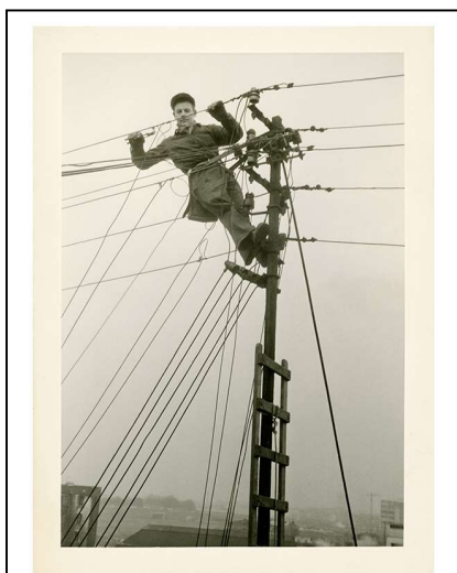
Un électricien en haut du potelet
