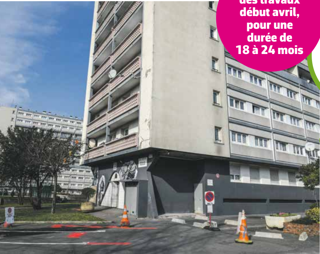
Les premières démarcations au sol annoncent le début imminent de la rénovation.
