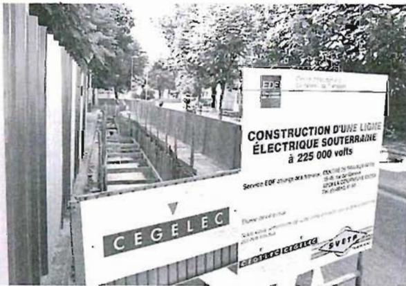
Préparation de la tranchée en vue de la pose d'une ligne électrique de 225 000 volts.
