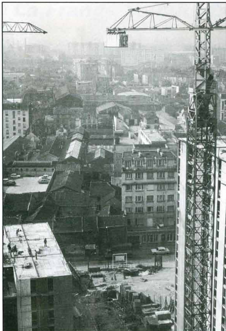
● Depuis 50 ans, le développement de la qualité de vie à Aubervilliers a toujours été lié à celui du service public. La construction de la cité Jules Vallès en 1967...
