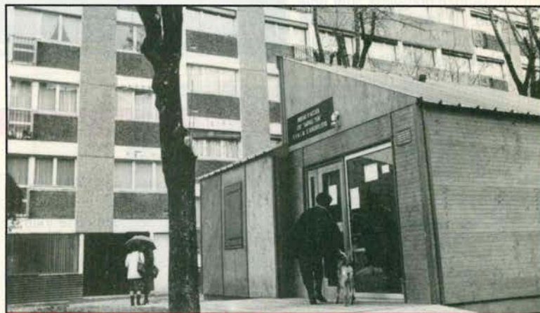
Allée Charles Gasperrin. Les travaux se poursuivent
