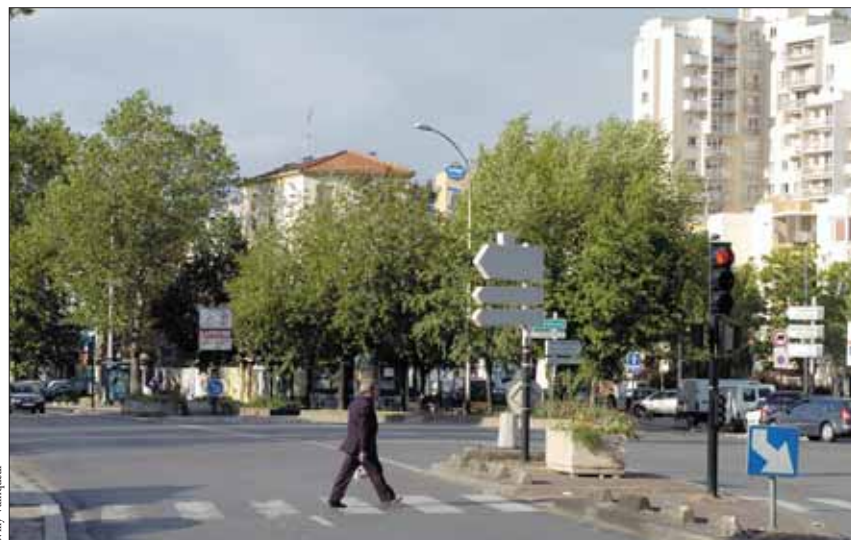
L'emprise principale du chantier sera située au Pont-de-Stains, c'est de là que rentrera en action le tunnelier.
