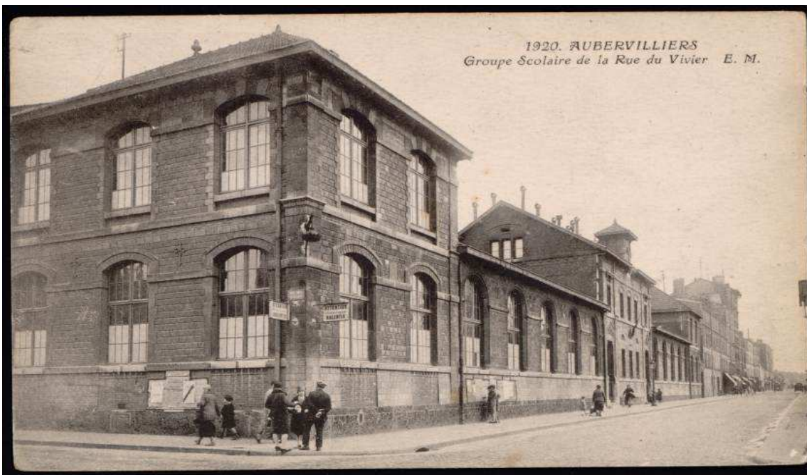
4Fi 20 - 1920. Aubervilliers - Groupe scolaire de la rue du Vivier.
