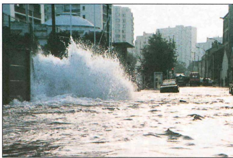
1987 Une canalisation cède rue Paul Bert. Les services techniques municipaux seront mobilisés plusieurs jours pour réparer les dégâts.
