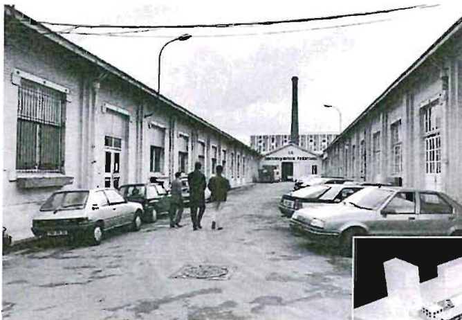
La « Doc » d'hier à demain : La cheminée de l'ancienne usine d'allumettes...
