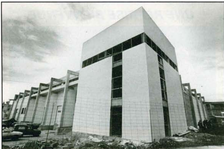
Les nouveaux locaux de la Sté Kiffer-Hamaide, avenue Victor Hugo sont en voie d'achèvement et contribuent à renforcer l'image industrielle de cette entrée de la ville.
