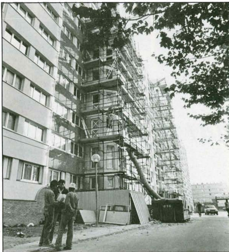
La réhabilitation a permis d'augmenter la surface des appartements.
